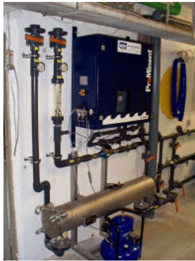
Figur 2.7: Ozonanlæg og partikel filter, Vestbadet 1999
