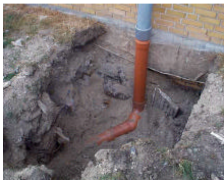
Figur 2.3: Nedløb omlagt til tør ledning, Vestbadet 1999
