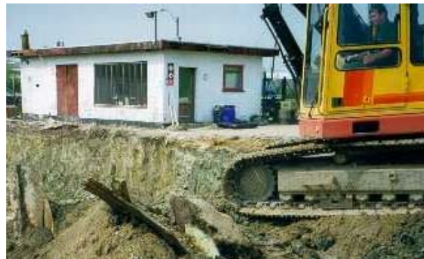
Opgravning af forurening tæt på bygning
